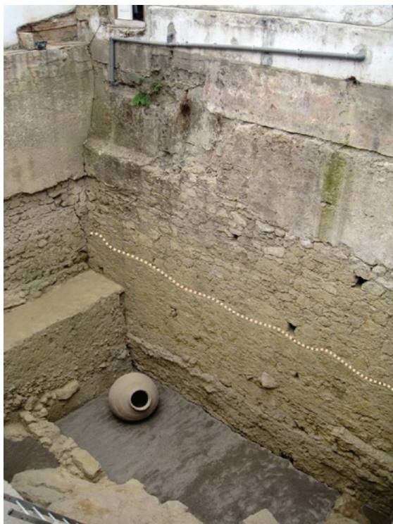
Figura 7 – Muro de contenção a sul do postcaenium . O traçado indica o limite do muro de época moderna (parte superior) e, inferiormente, a estrutura romana.
